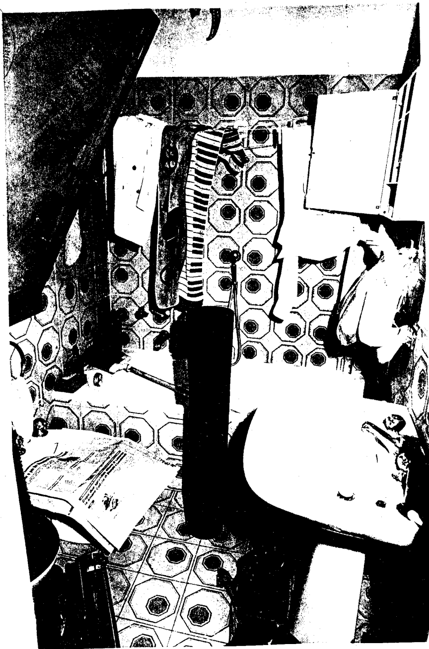
169)-Ripresa del bagno, con riferimento al rotolo di materiale plastico sul pavimento;
