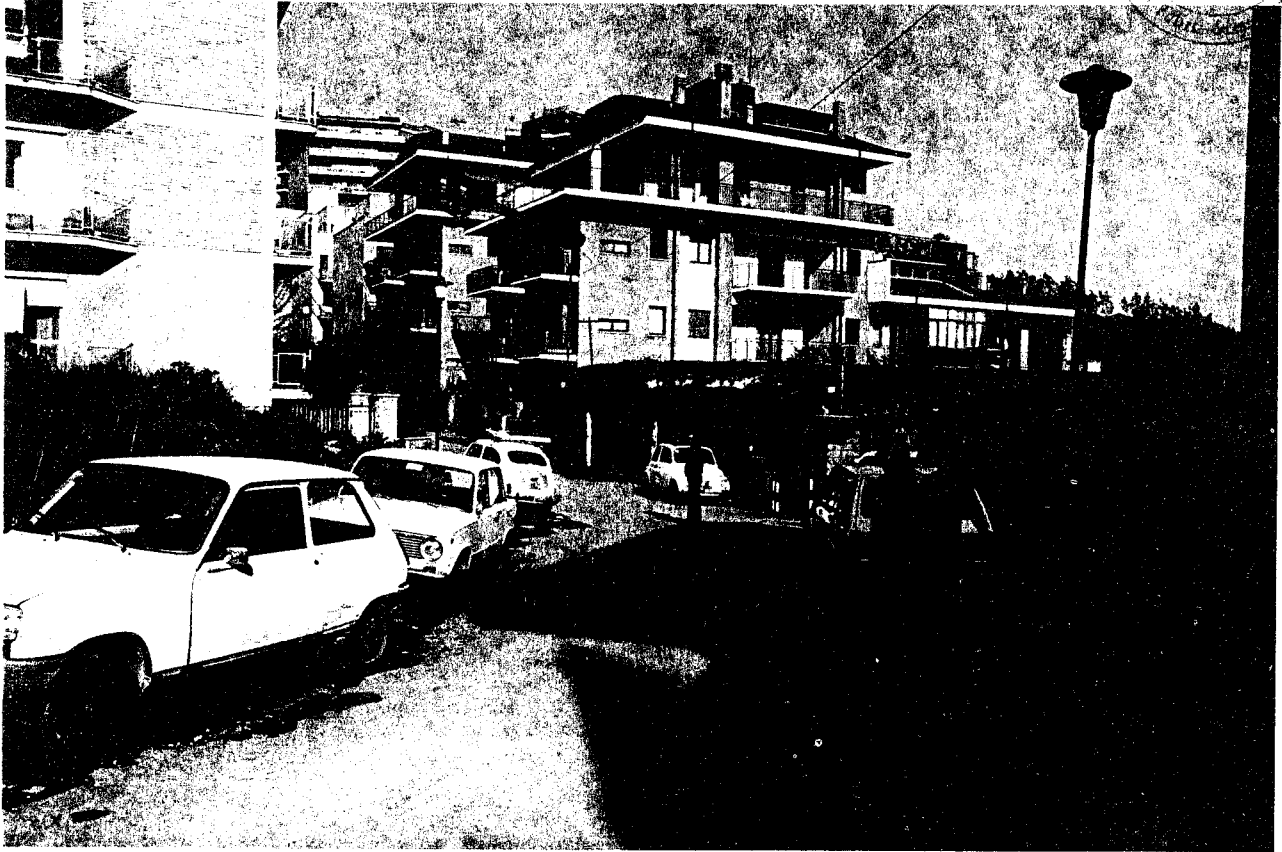
5)-Panoramica di via gradoli ripresa dal lato della campagna; la freccia indica la palazzina di cui al rilievo precedente;
