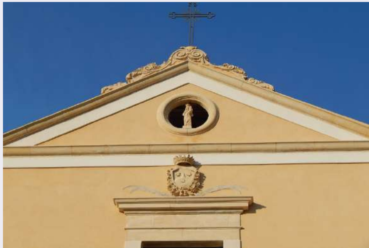
Particolare facciata .jpg
